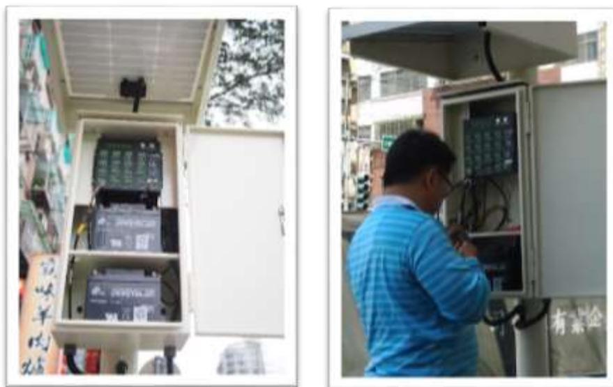
照片 1：雨水下水道水位計資料讀取及電池更換
